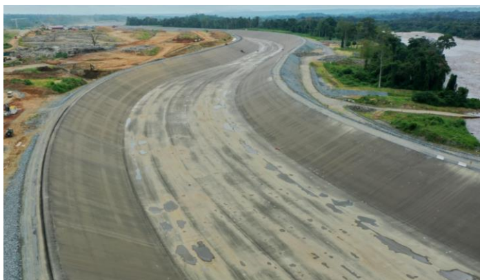
Photo du canal d'amenée sec avant le test d'étanchéité
