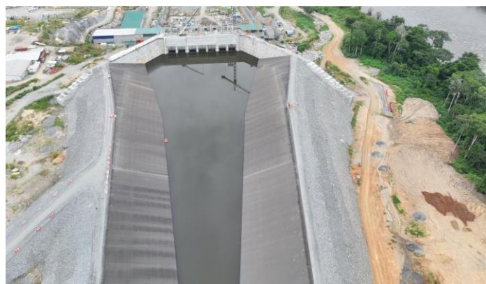
Photo du canal d'amenée partiellement rempli
