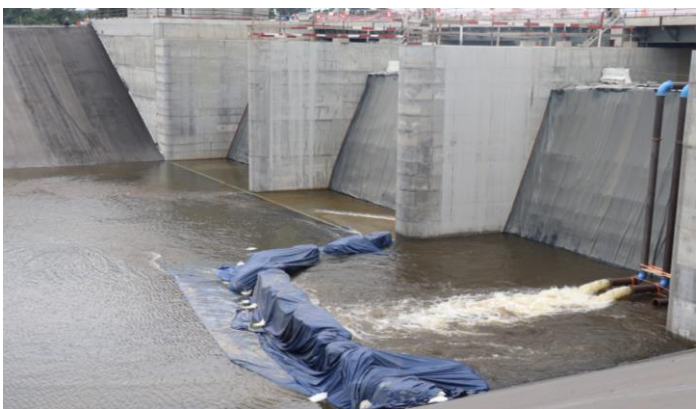
Processus de remplissage du canal d'amenée
