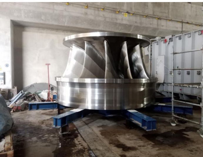
Roue turbine n°4 sur la plage de montage
